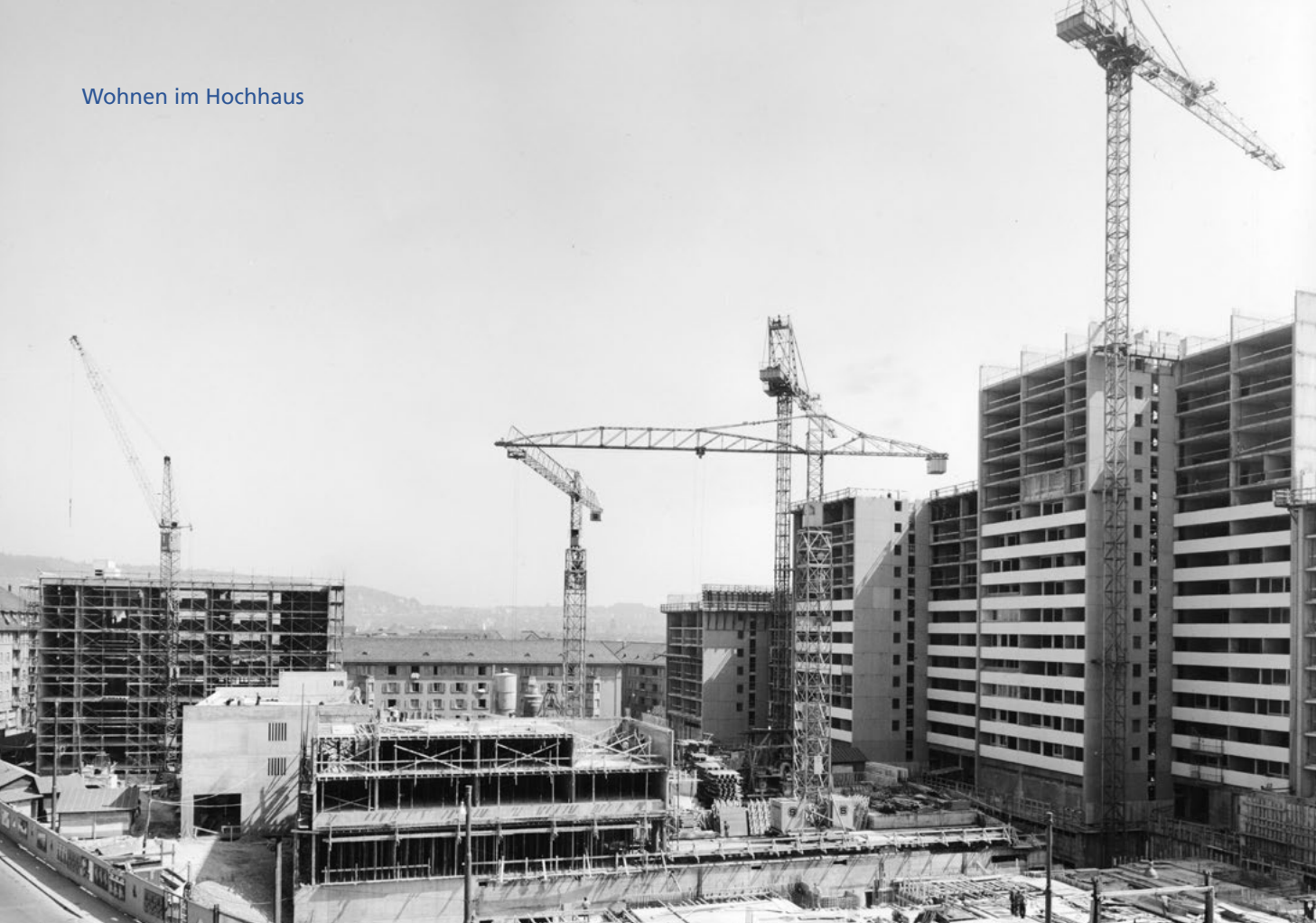
Bau des Zürcher Locherguts im Jahr 1965
