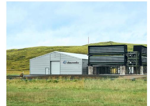
Die Climeworks Direct Air Capture Technologie nutzt ausschließlich erneuerbare Energie und die modularen CO<sub>2</sub>-Kollektoren können zu beliebig großen Maschinen kombiniert werden.
