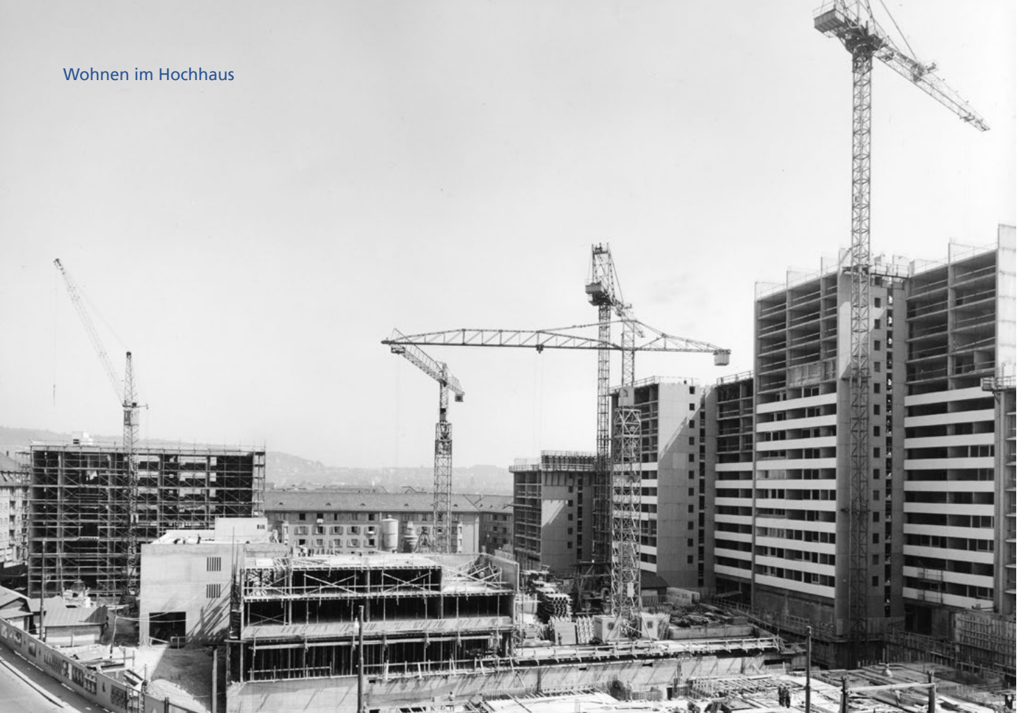
Bau des Zürcher Locherguts im Jahr 1965
